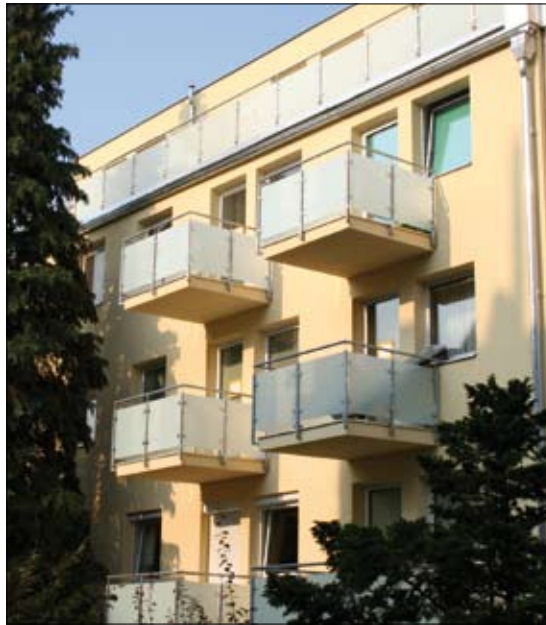
Ein von uns saniertes Wohnhaus in Wien-Währing
